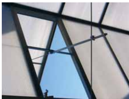
Selbstverständlich auch im eigenen Haus im Einsatz: Rauch-Wärmeabzug-Anlage bei Fortmeier
